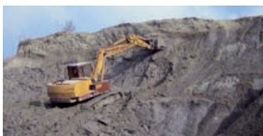
Reacondicionamiento de una zona de anidamiento. Fuente: Guide de promotion de l'hirondelle de rivage en Suisse. Conseils pratiques pour la gestion des colonies dans les carrières et la construction de parois de nidification.
