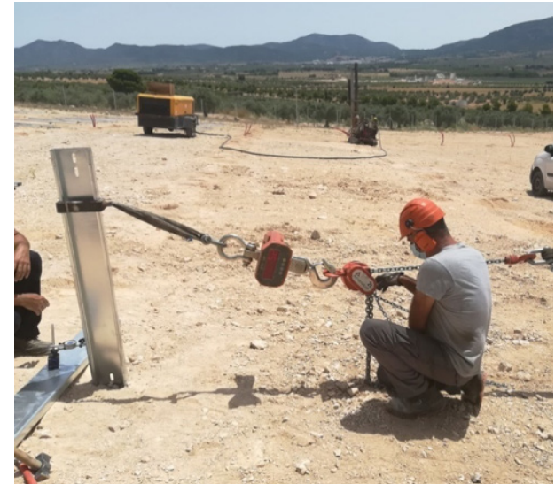
ILUSTRACIÓN 19: Ensayo de cortadura
