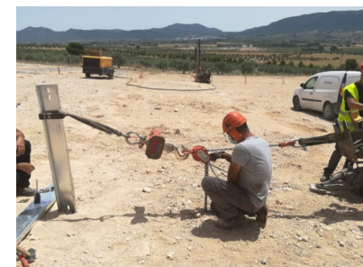
ILUSTRACIÓN 12: Ensayo de cortadura
