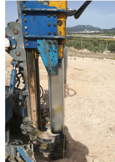
ILUSTRACIÓN 11: Ensayo de tracción
