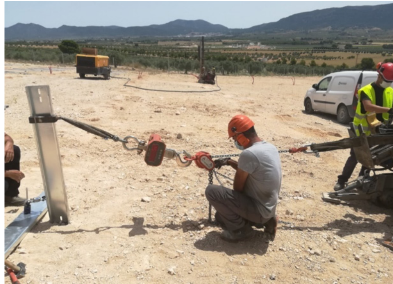
ILUSTRACIÓN 4: Ensayo de cortadura
