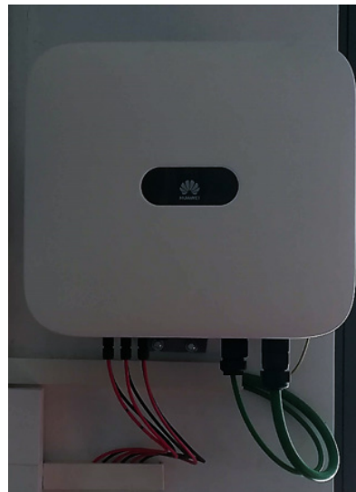
ILUSTRACIÓN 13: Inversor Huawei
