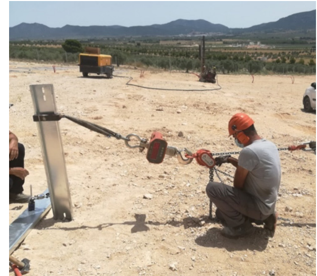
ILUSTRACIÓN 35: Ensayo de cortadura
