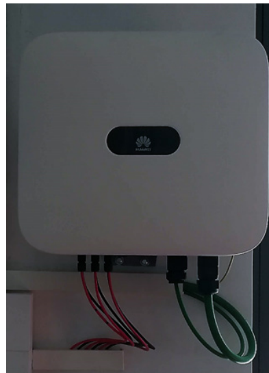
ILUSTRACIÓN 36: Inversor Huawei
