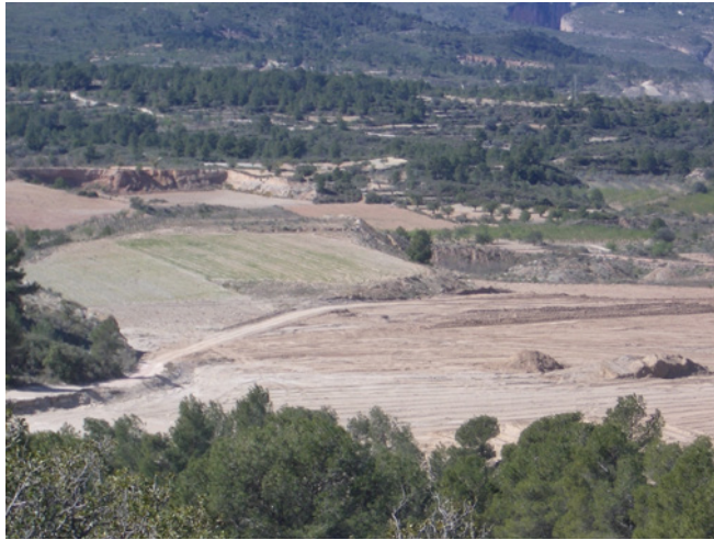
Detalle de las superficies en proceso de reperfilado, nótese las dos plazas contiguas a diferente nivel y la existencia de un camino.
