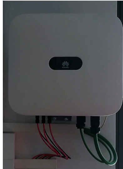
ILUSTRACIÓN 5: Inversor Huawei
