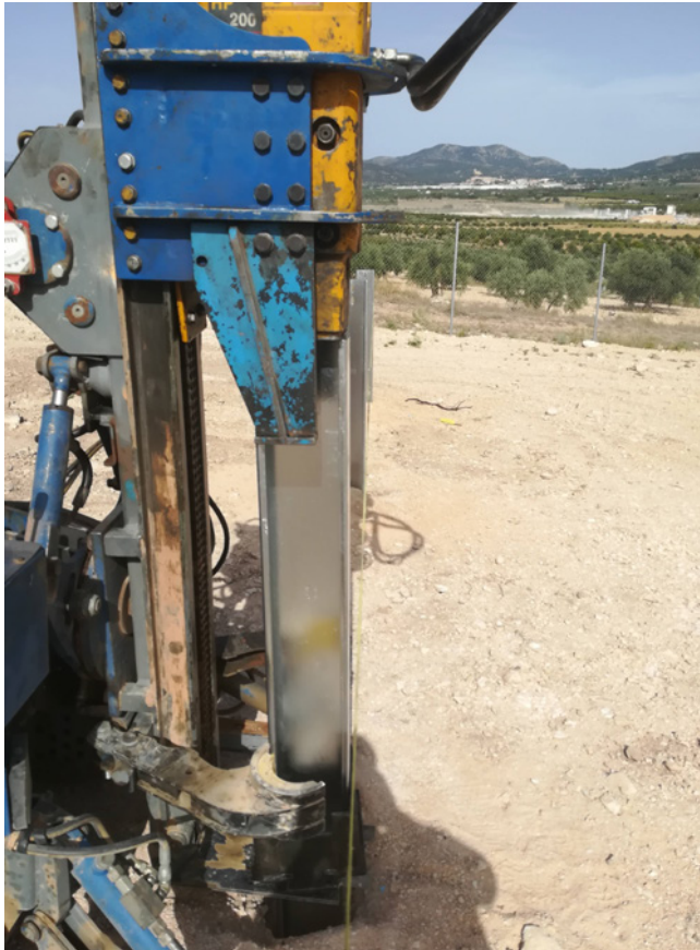
ILUSTRACIÓN 3: Ensayo de tracción
