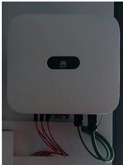
ILUSTRACIÓN 25: Inversor Huawei
