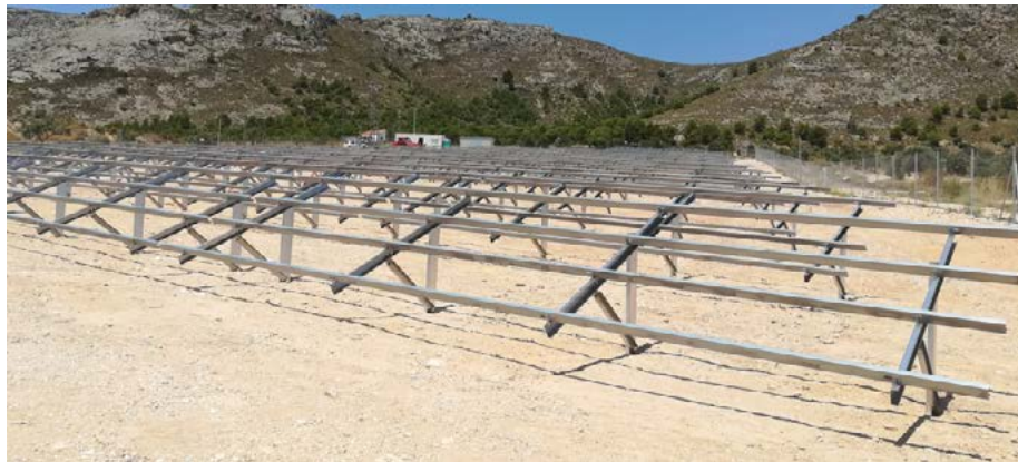
ILUSTRACIÓN 10: Estructura hincada monoposte
