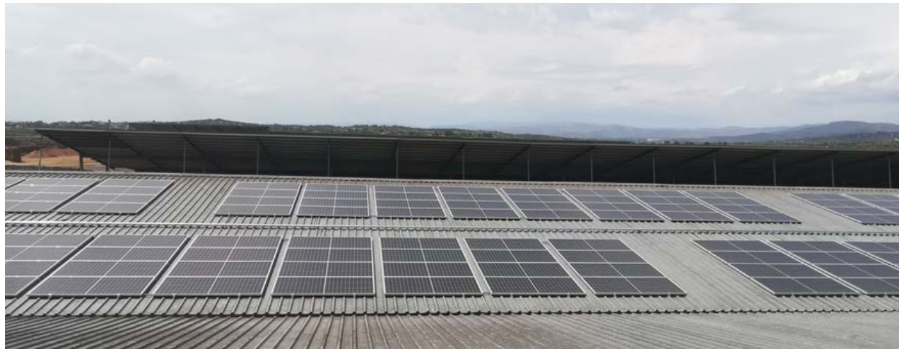
ILUSTRACIÓN 28: Estructura coplanar
