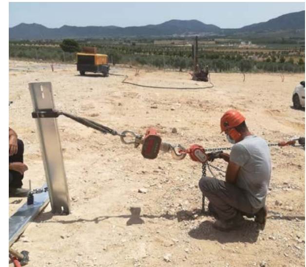
ILUSTRACIÓN 35: Ensayo de cortadura
