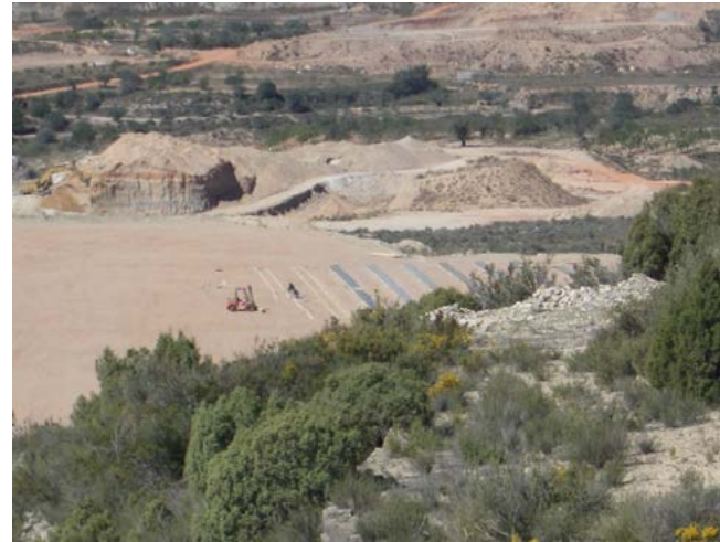
Detalle de los trabajos de instalación de las placas. Al fondo puede verse el desarrollo de las labores de restauración, con el aporte de estériles de la explotación, para relleno de huecos mineros.
