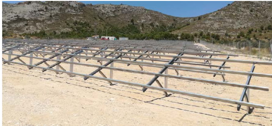
ILUSTRACIÓN 33: Estructura hincada monoposte
