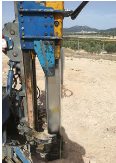
ILUSTRACIÓN 18: Ensayo de tracción
