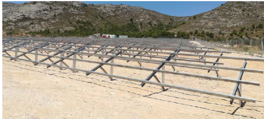
ILUSTRACIÓN 2: Estructura hincada monoposte
