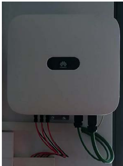
ILUSTRACIÓN 25: Inversor Huawei
