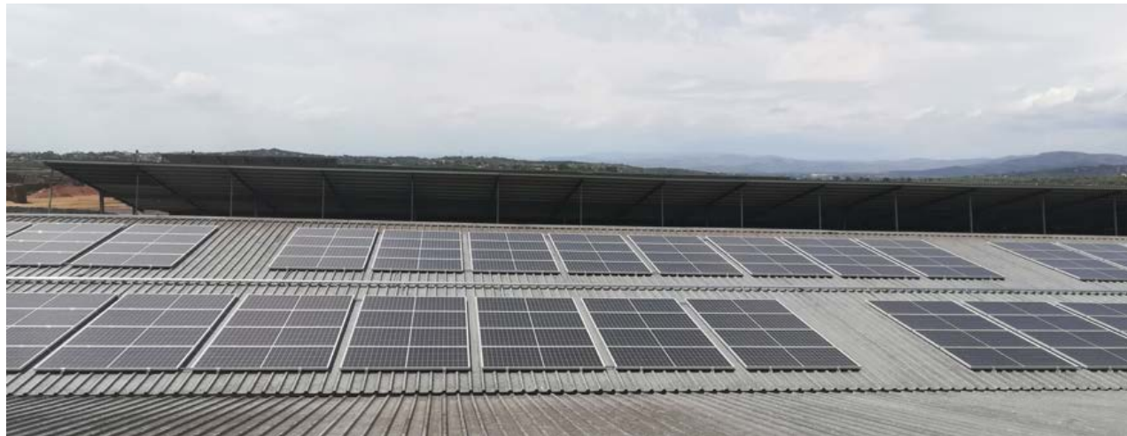
ILUSTRACIÓN 23: Estructura coplanar
