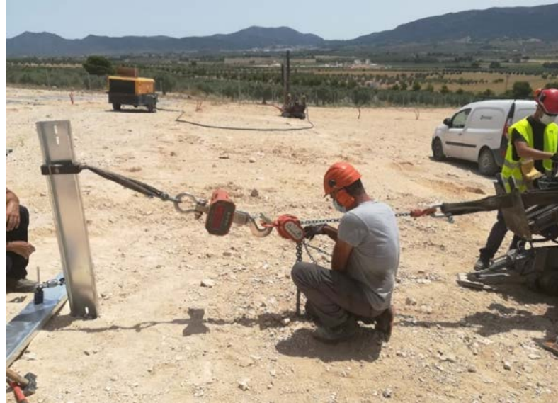
ILUSTRACIÓN 4: Ensayo de cortadura
