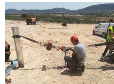
ILUSTRACIÓN 12: Ensayo de cortadura
