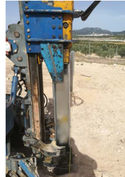
ILUSTRACIÓN 11: Ensayo de tracción
