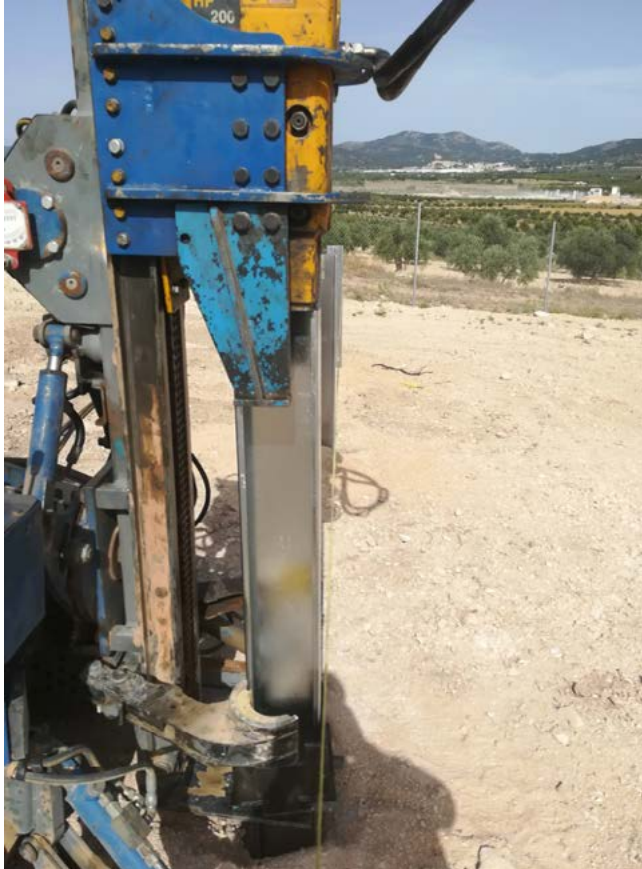
ILUSTRACIÓN 3: Ensayo de tracción
