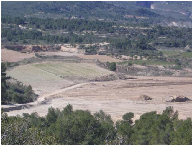
Detalle de las superficies en proceso de reperfilado, nótese las dos plazas contiguas a diferente nivel y la existencia de un camino.
