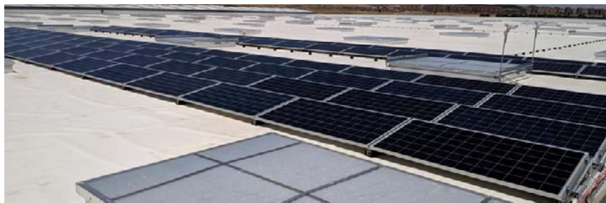
ILUSTRACIÓN 29: Estructura metálica lastrada
